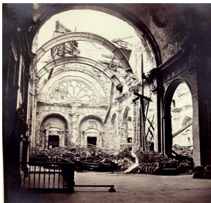
Salle des pas perdus, nef du sud, côté ouest, vue après l'incendie de 1871.
