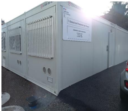
Locaux provisoires -TP THANN
