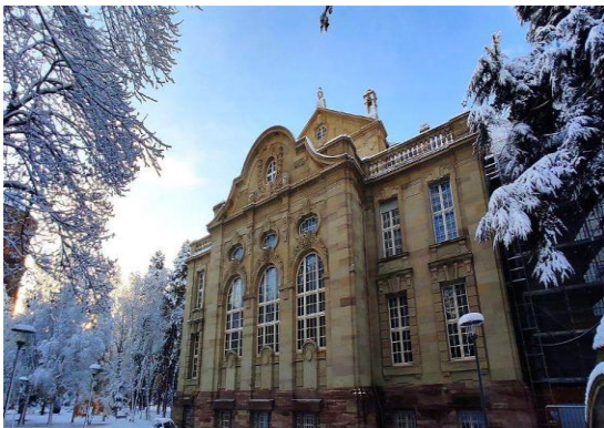
Façade nord – CA de Colmar.
