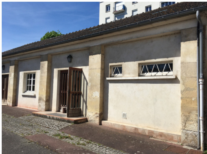
Vue extérieure du bâtiment
