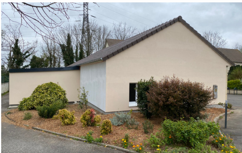
Vue de l'arrière du bâtiment
